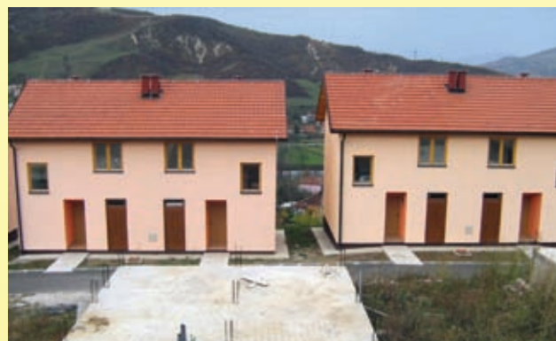
Dolača - stambeni objekti
